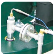
可偵測蒸汽的溫度，當溫度超出設定值時自動斷電停機，確保鍋爐運轉安全。
