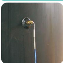
可偵測水管溫度，以檢測鍋爐是否有產生水垢。若偵測到溫度上升至設定溫度時，則鍋爐會自動停止運轉。
